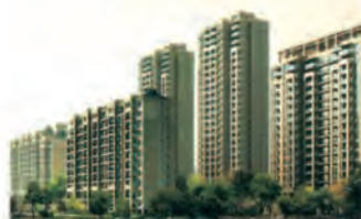
▲ 小区自来水配管
