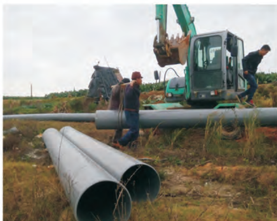
▲ 厦门同安农村饮水工程
