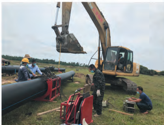
▲ 海南PE管自来水工程
