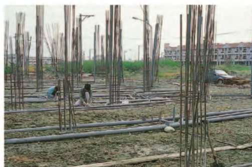
▲建筑工程 Construction engineering
