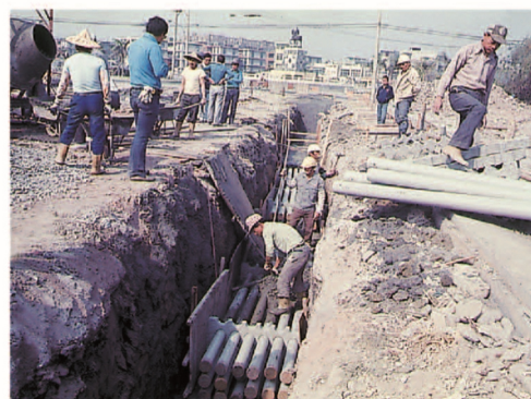
▲ 电气工程 Electrical engineering
